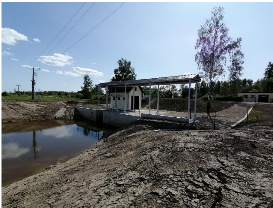
4. attēls. Strimēnu sūkņu stacija pēc pārbūves, 01.08.2023.
