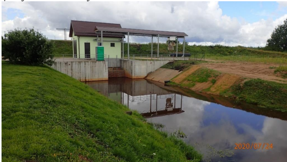
2. attēls. Silzemnieku sūkņu stacija pēc pārbūves, 2020.
