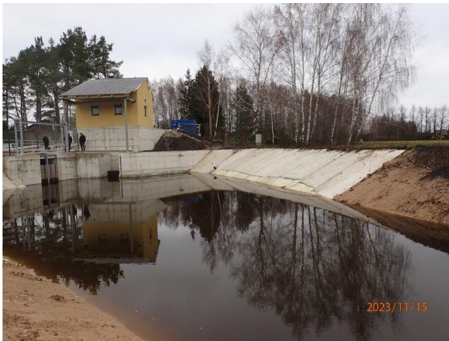
5. attēls. Valgundes 1 sūkņu stacija pēc pārbūves, 15.11.2023.
