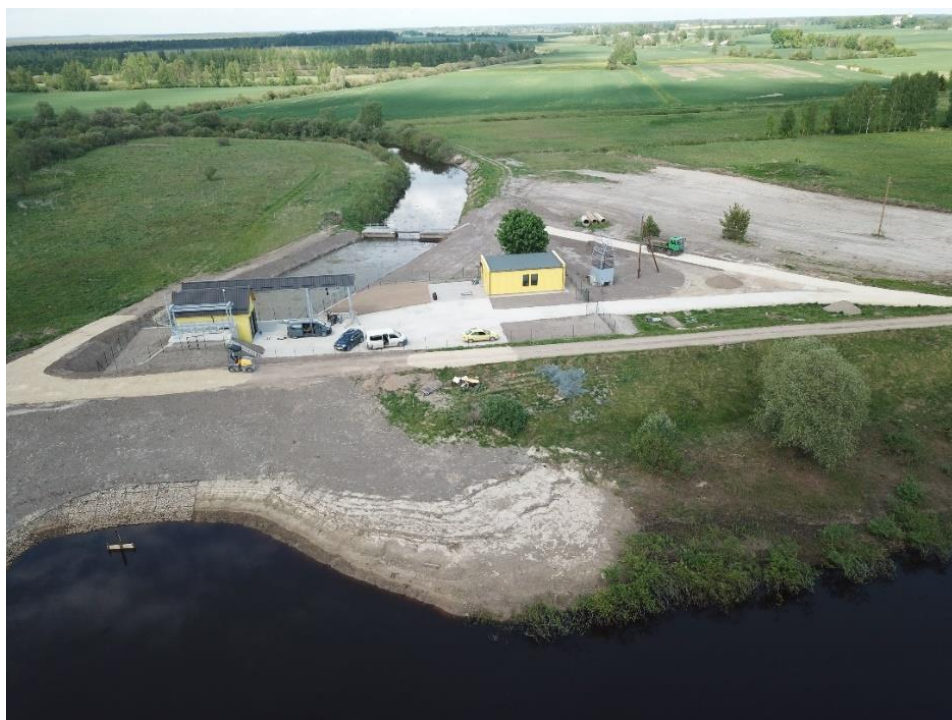
3. attēls. Dziļāunes sūkņu stacija pēc pārbūves, 13.07.2023
