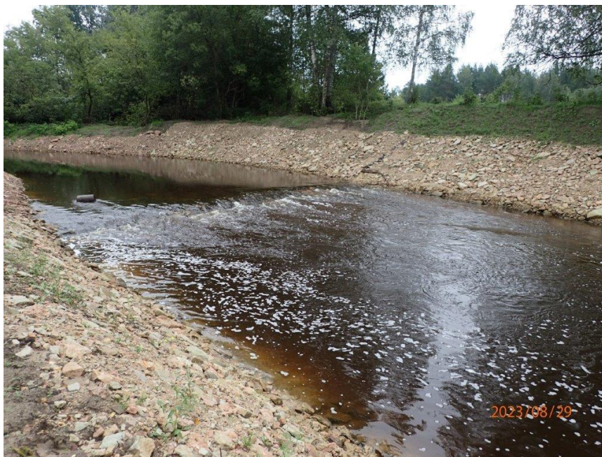
10. attēls. VNŪ Iecava, izbūvētais sliekšnis, 2023
