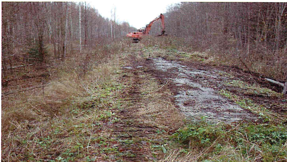
Bebru postījumu remonts dambim D-1 pik. 55/00
